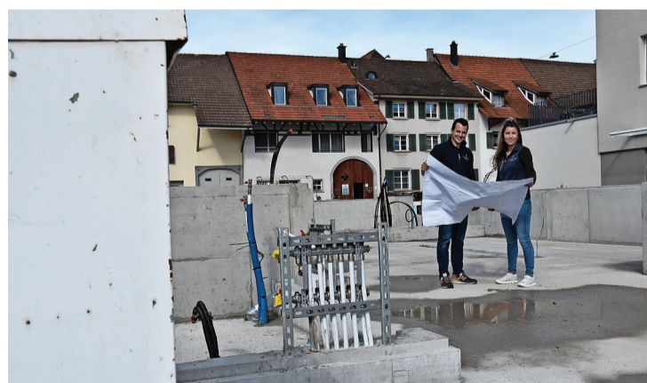
Rico und Janine Gysel auf ihrer Baustelle an der Hauptstrasse.
